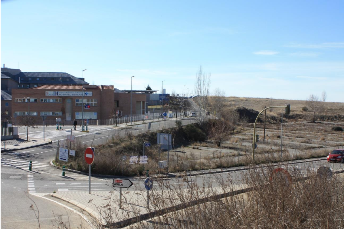
Figura 31. Vista del extremo noreste de la parcela, en la que se aprecia el vaciado parcial del terreno. Fuente: Documento de Avance del PRAT
